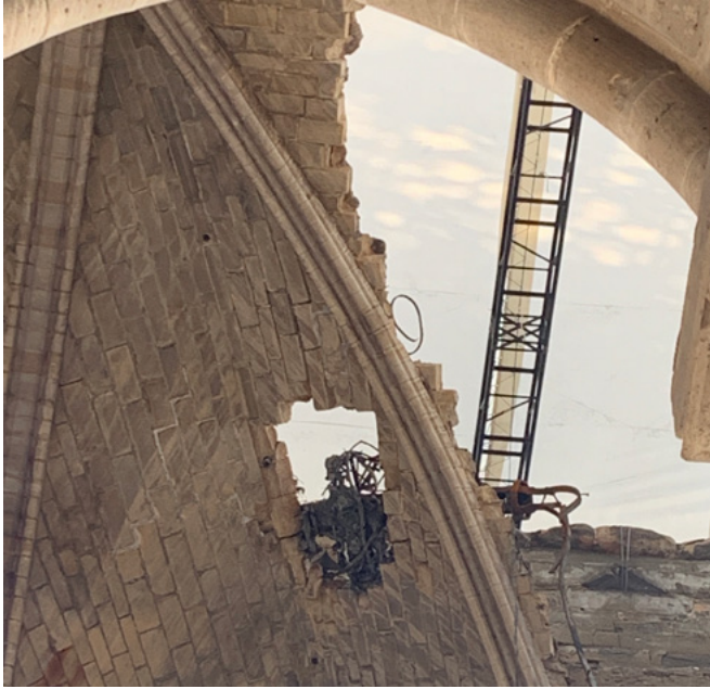
Fig. 10. Voûtes de la nef, Photo Philippe VILLENEUVE
