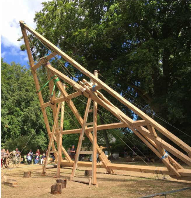
Fig. 11. Levage d'une ferme de la nef reconstituée à l'identique
